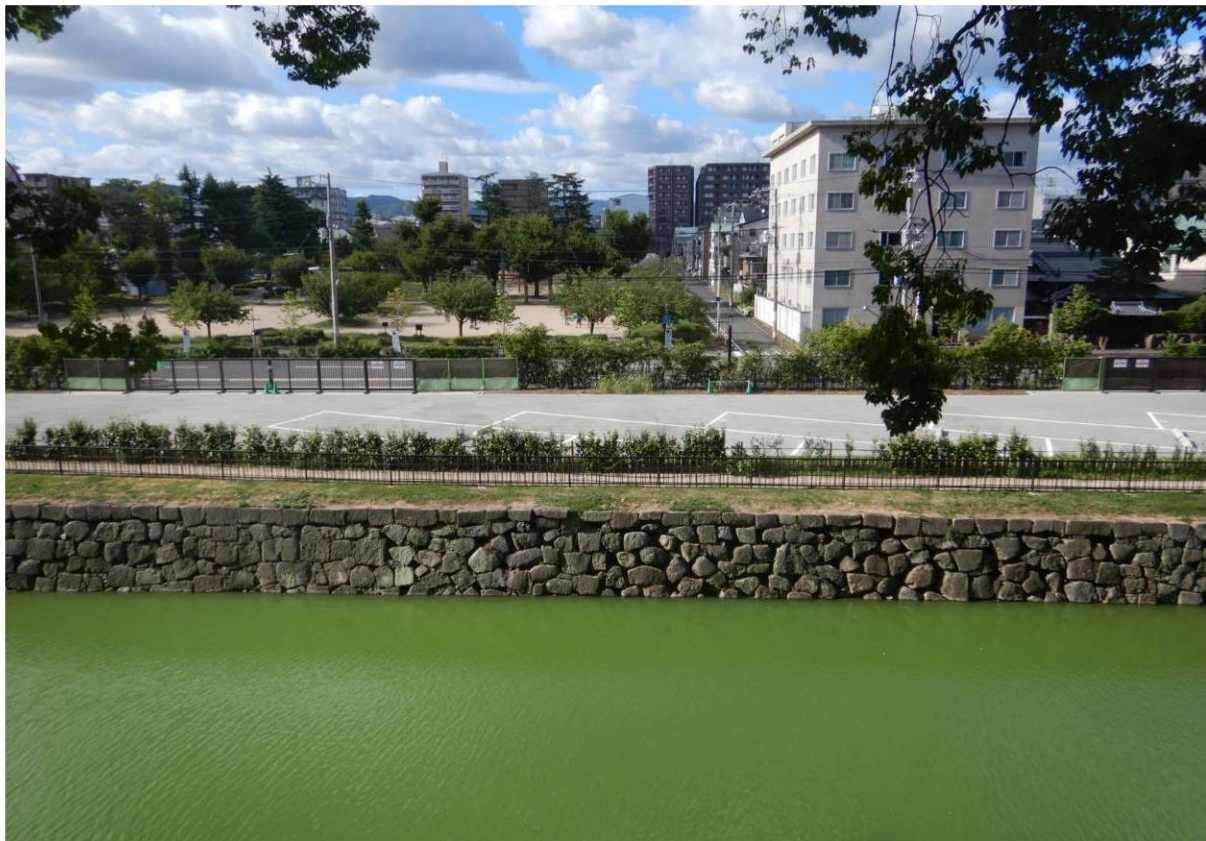
（参考）石垣写真（基準点 A から撮影（正面が観測点 4））
