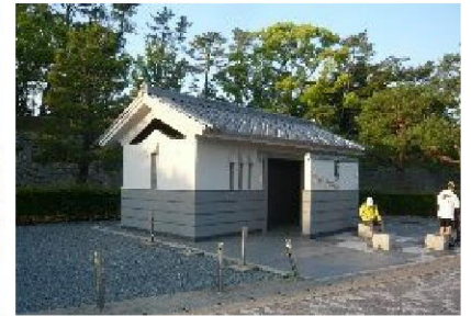
便所(二条城外濠公衆トイレ)
