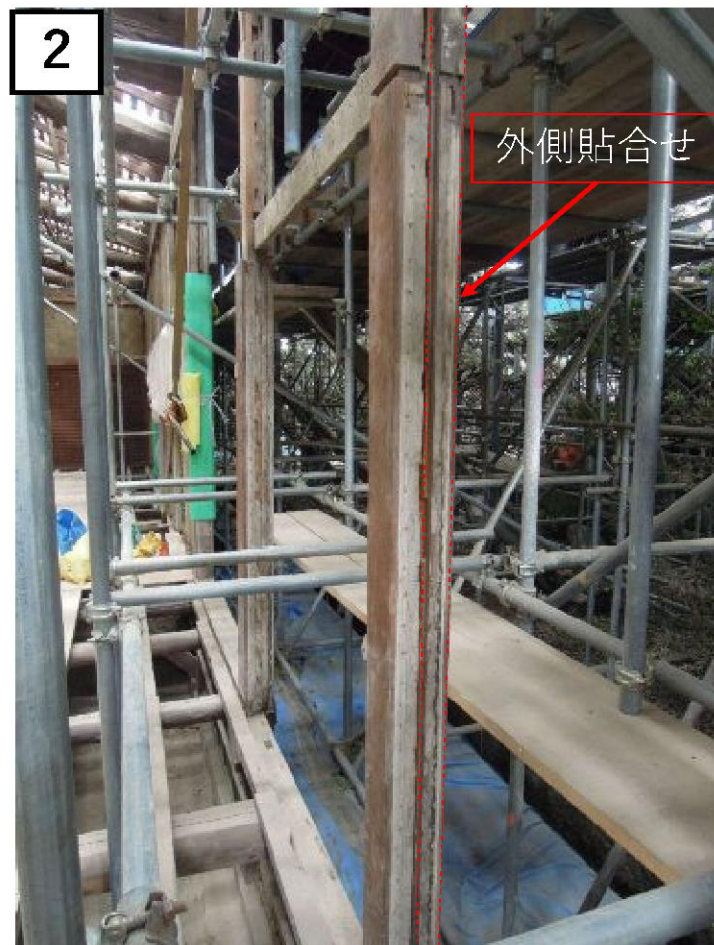
みなみろうかしたがわばしら 南廊下側柱
