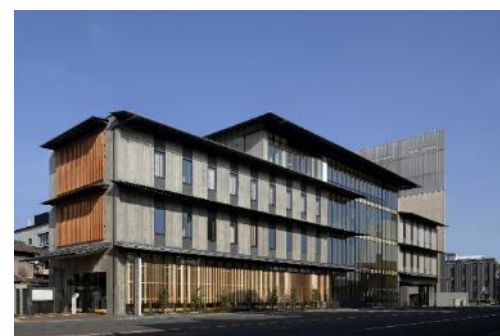
上京区総合庁舎
