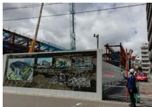
建設現場における騒音の測定
