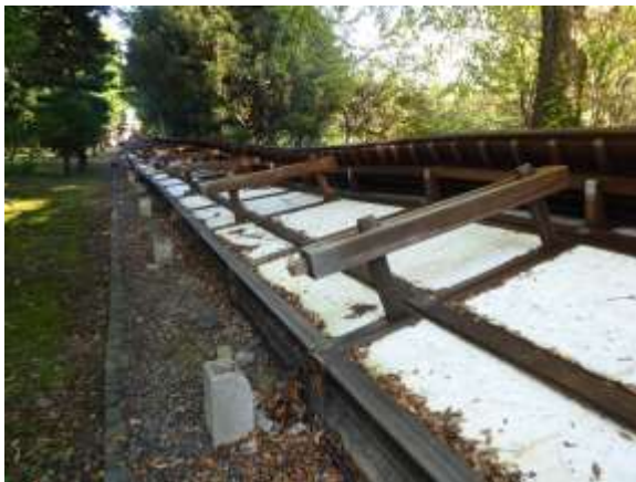
二之丸御殿北長押堀 南面 台風 21 号による倒壊状況
