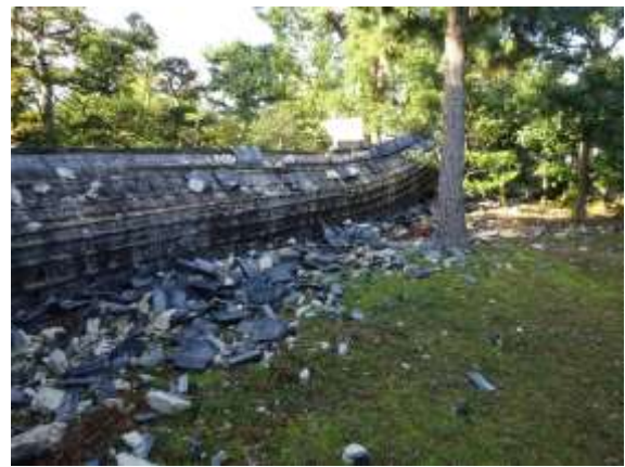
二之丸御殿北長押堀 北面 屋根廻り・瓦の破損状況
