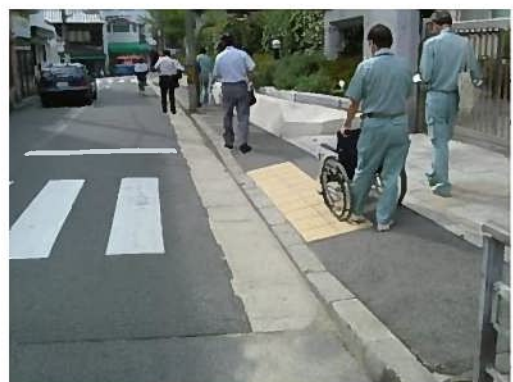
生活関連経路Ⅱ〔泉涌寺道〕（整備前）
