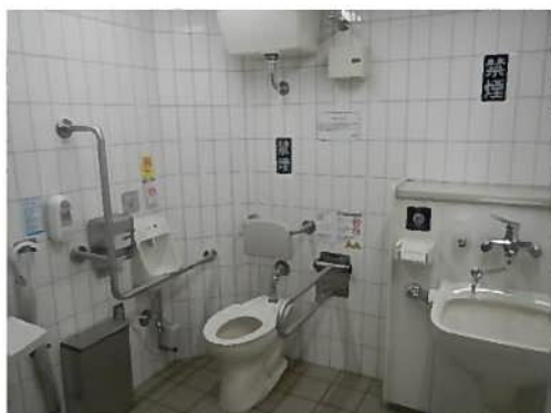
(ウ) オストメイト対応トイレへの改良
