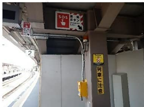
J R 東福寺駅 非常停止ボタンの設置
