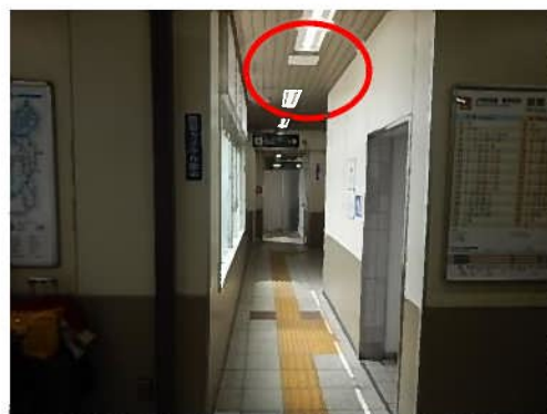
(エ) トイレの出入口における 音響案内装置の設置
