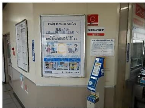
J R 東福寺駅 駅員呼び出しボタンの設置
