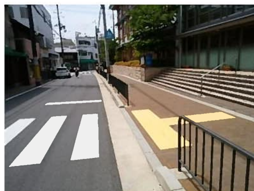
生活関連経路Ⅱ〔泉涌寺道〕（整備後） 【段差・勾配の改善】
