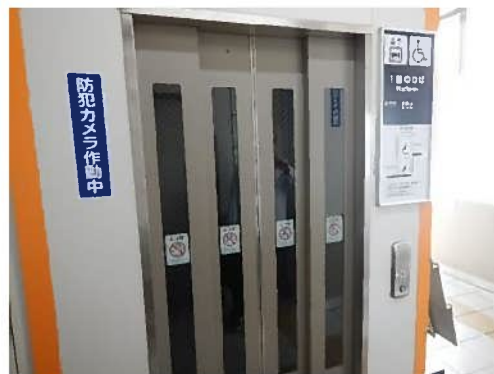
(ア) エレベーターの設置
