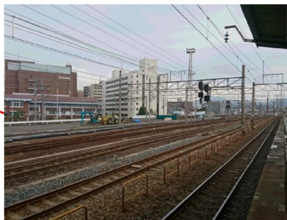
実施中の線路移設工事の状況
