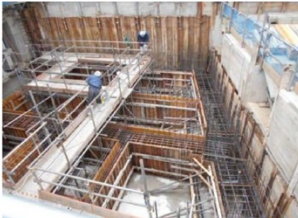
阪急西院駅 駅舎建替工事
