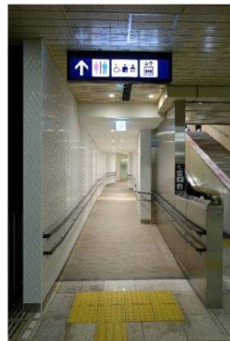
トイレ前アプローチの段差解消 （写真：京都駅）
