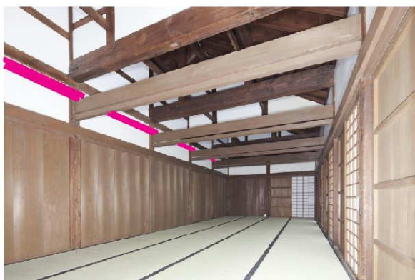
耐震補強材取付
