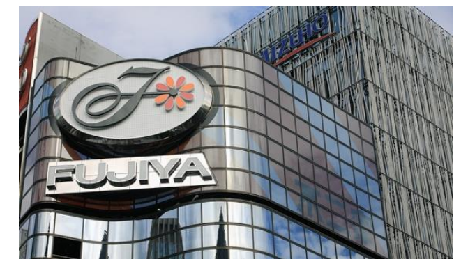
デザイン協議で誘導したメディアファサード
