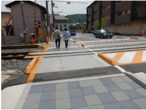
1 十条通 ・ 両側セミフラットの歩道
