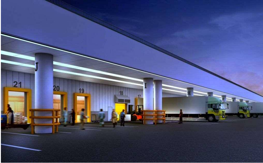
入荷用トラックバース（夜景・新千本通側）
