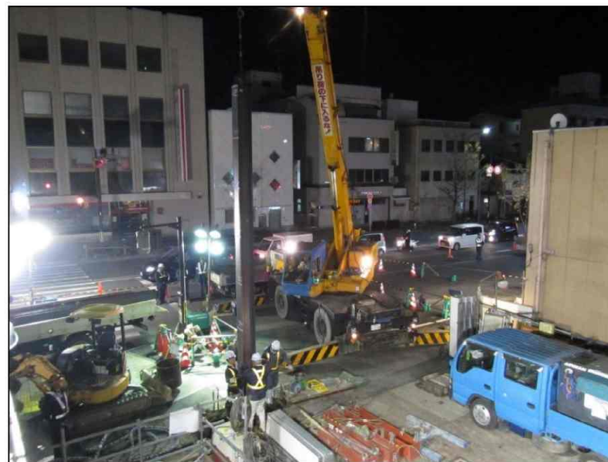
（阪急下り線側）地下連絡通路構築状況
