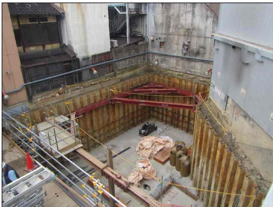
（阪急西院ビル）南側躯体解体状況
