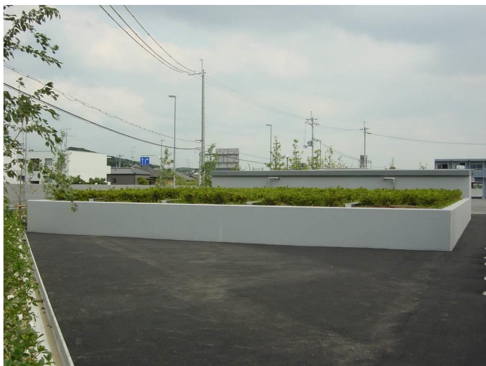
十条土壤脱硝施設
