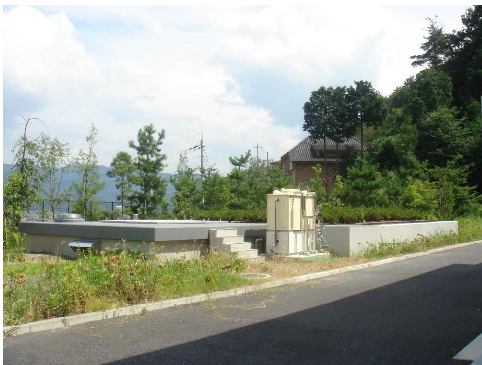
山科土壤脱硝施設
