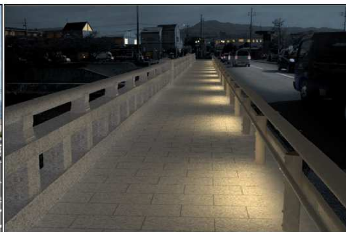
【歩道照明】 手摺照明
