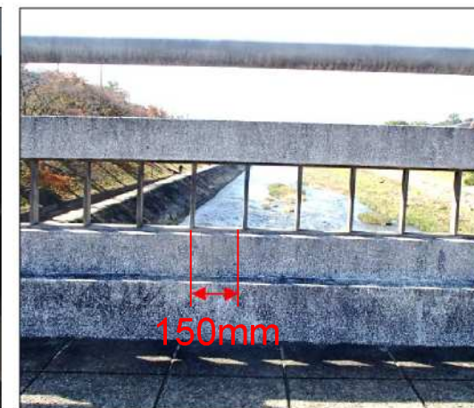
【高欄】 転落防止 : 縦桟
