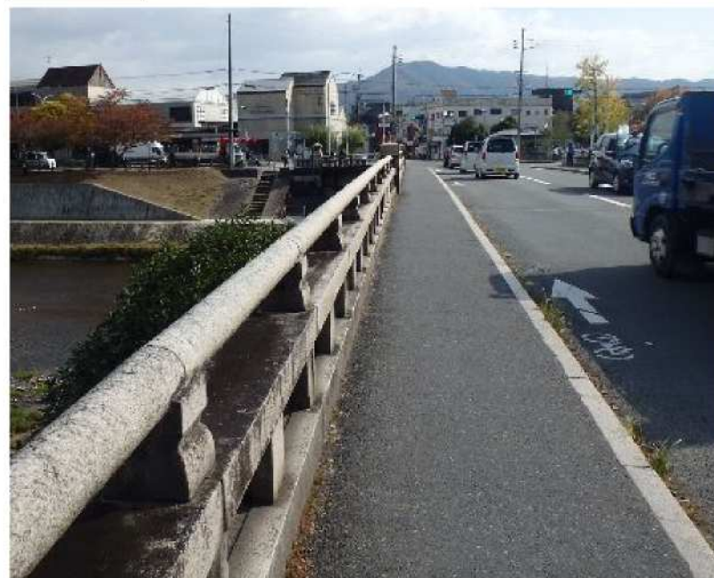
アスファルト舗装
