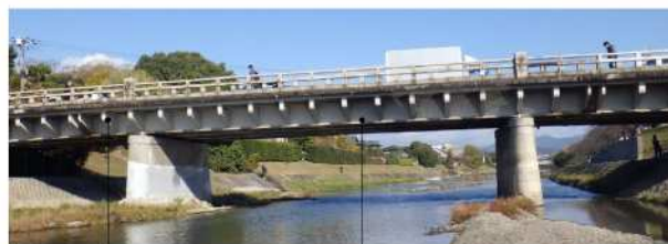
ブラケット (支持具) 橋桁の塗装
