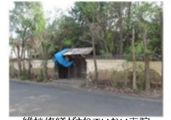
維持修繕がされていない寺院
