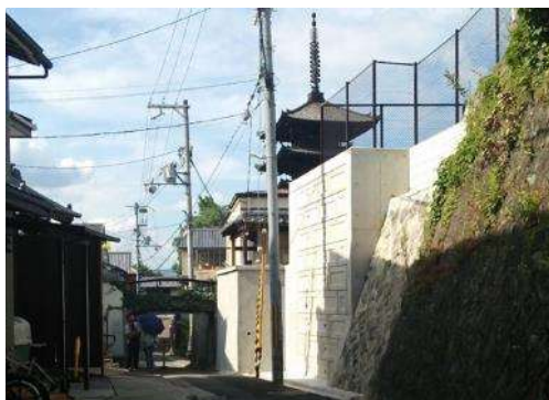
新しい直立のコンクリート擁壁 ＜清水寺エリア＞（美観地区）
