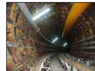
山科三条雨水幹線(整備中)
