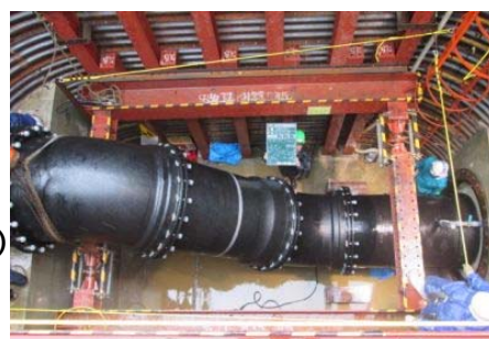
水道配水管工事
