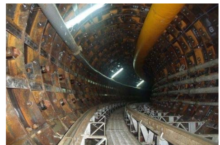
山科三条雨水幹線（山科駅周辺地区）
