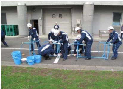
応急給水訓練（仮設給水栓の組立作業）
