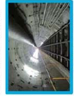
雨水幹線の整備
