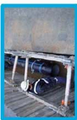
耐震管の布設
