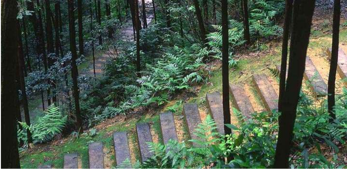
散策路入口付近（階段には近鉄電車の枕木を使用している）
