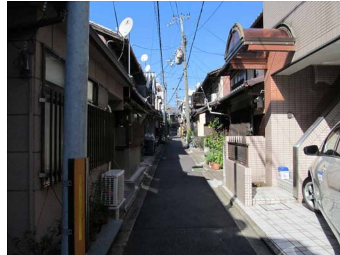
写真 39 壬生寺周辺の町家が残る町並み
