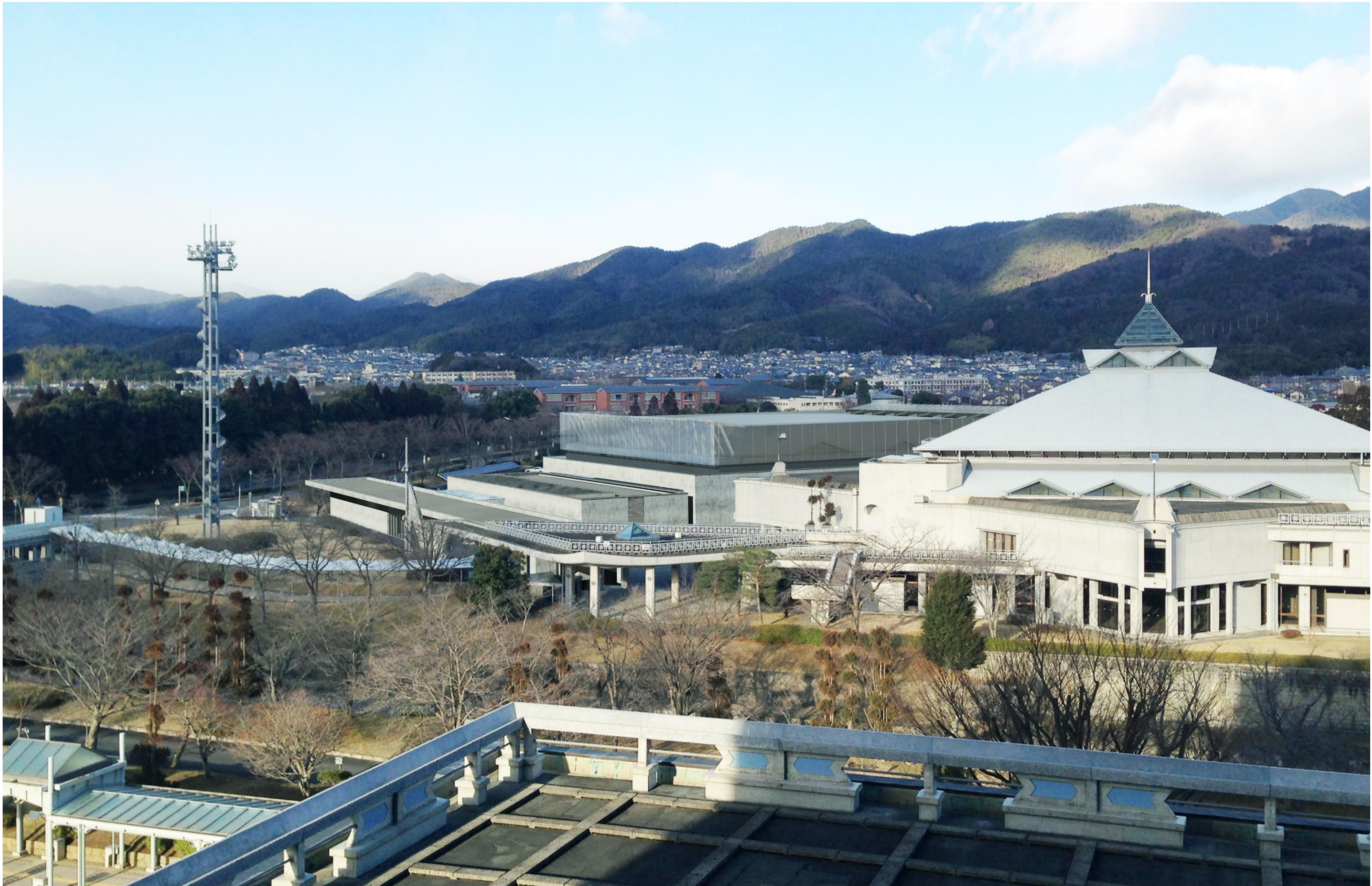
近景 本館5階より
