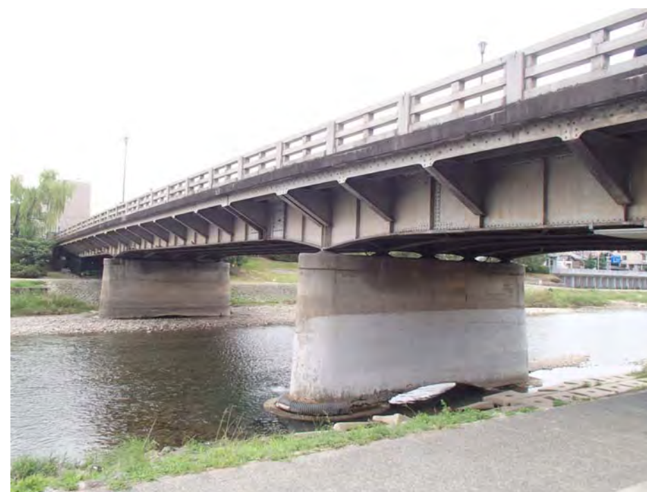
二条大橋 (橋長: 85 m)
