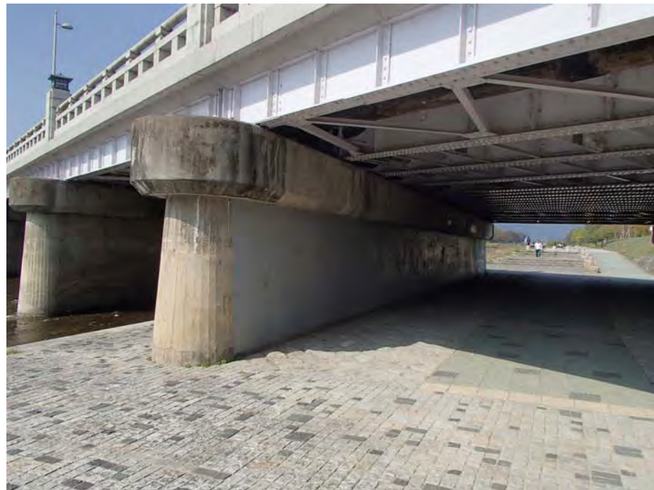
外桁構造 (ブラケットなし)
