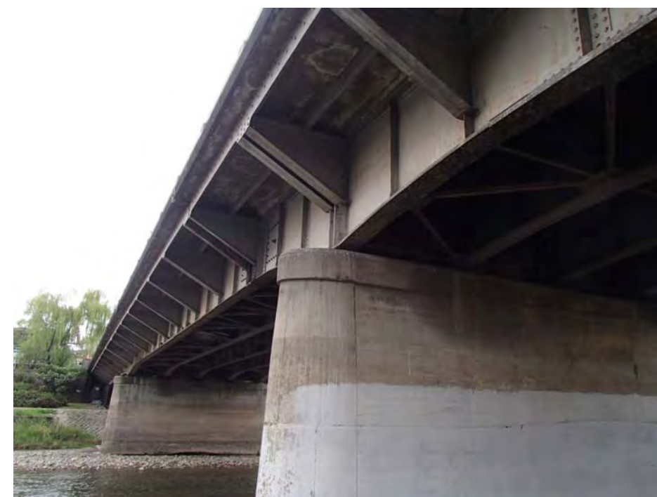
架設当初からバルコニーを考慮していない
