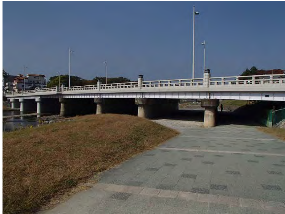
外桁構造 (ブラケットなし)
