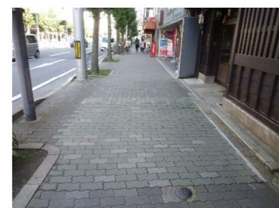
3 河原町通 以西(インターロッキング)
