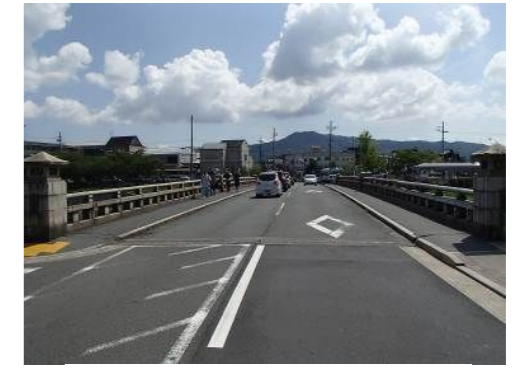
河合橋(西から東を望む)
