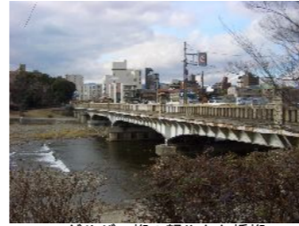
ゲルバー桁の軽やかな橋桁
