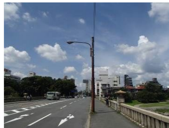
道路照明・歩道灯籠照明色
