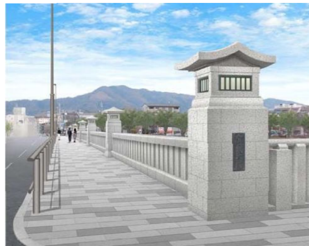
石製高欄の嵩上げ ( 1.0m 1.1m )
