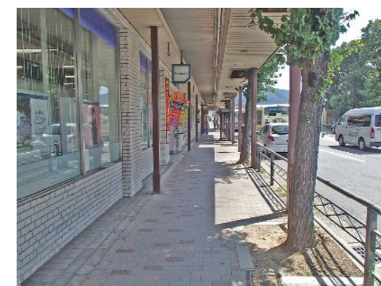
2 賀茂大橋~河原町通間(インターロッキング)
