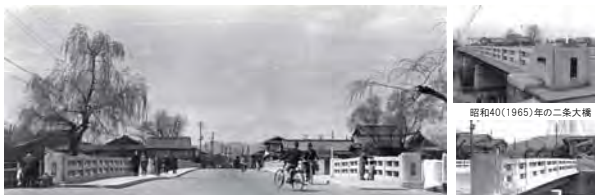
昭和28(1953)年の二条大橋 昭和40(1965)年の二条大橋(小橋)
