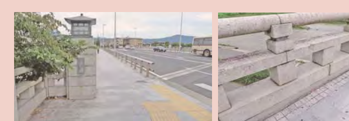
↑嵩上部事例(共に北大路橋)
