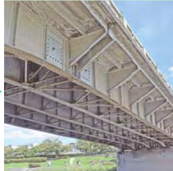
⑤橋桁の塗装
