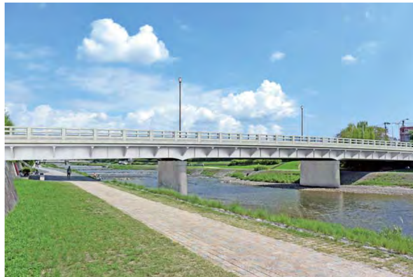
A 案 青みがかったグレー(現況塗装色)
