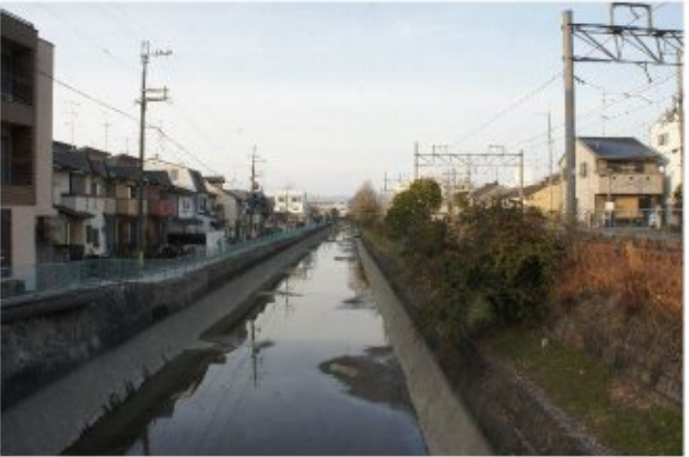
写真⑫ 疏水（北向き）
