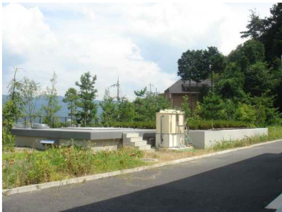
山科土壤脱硝施設
