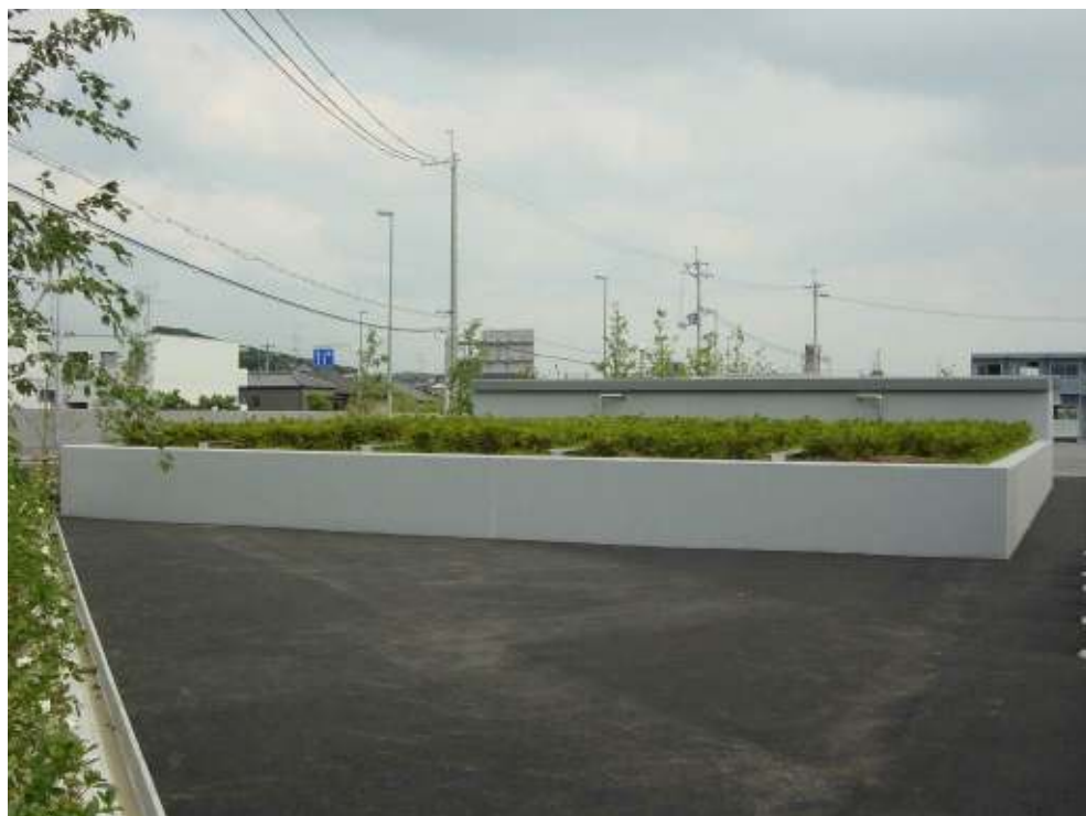
十条土壤脱硝施設
