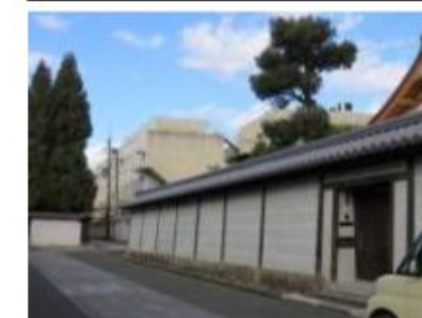
写真 30 境内地から見える校舎
