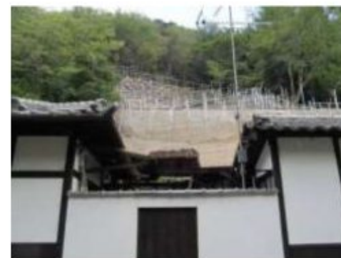
写真 4 復旧工事中の境内斜面
