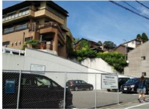
写真 24 構内への斜路と一体化された 大規模な擁壁
