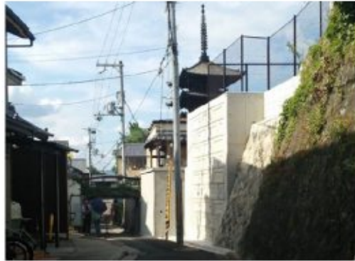
写真 23 敷地境界に直立する コンクリート擁壁
