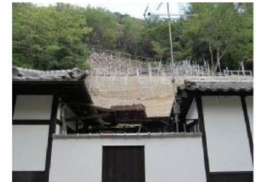
写真 4 復旧工事中の境内斜面
