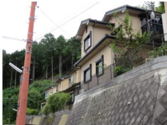
写真：西芳寺 19 擁壁の住宅地
