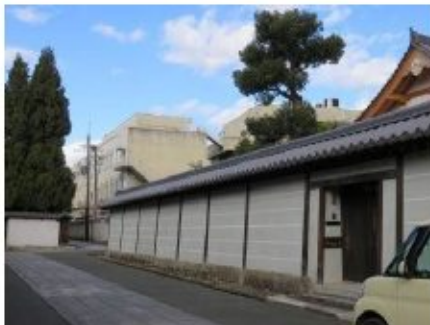
写真 30 境内地から見える校舎
