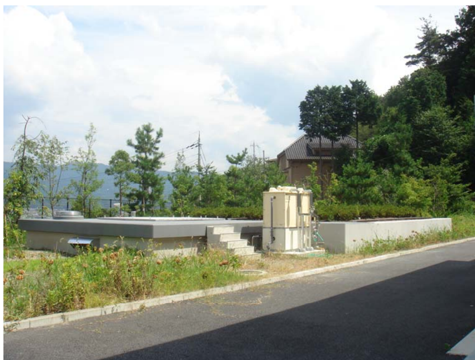
山科土壤脱硝施設
