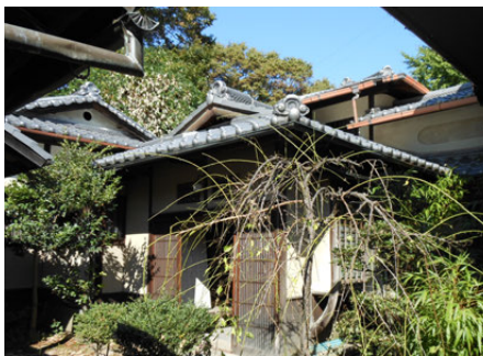
古い遺構を残す玄関口
