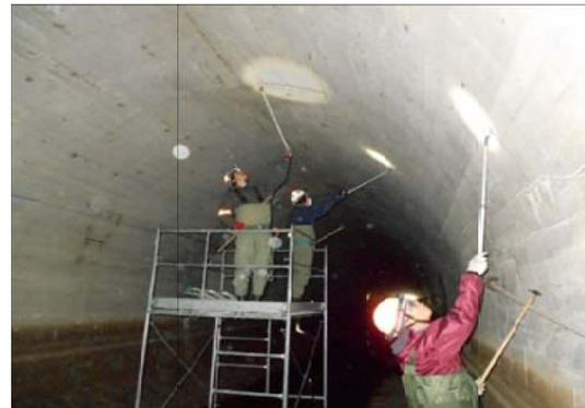
写真ー2 打音検査状況
