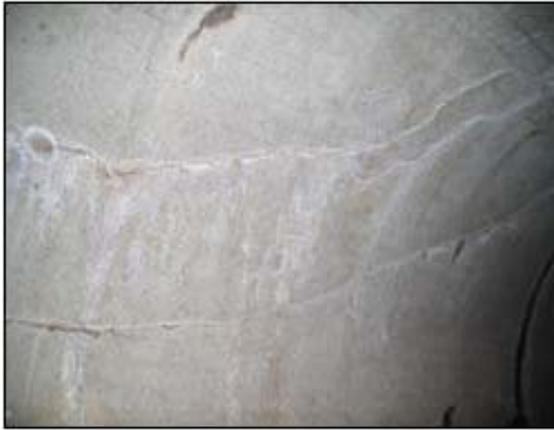
写真-8 斜め方向のひび割れ
