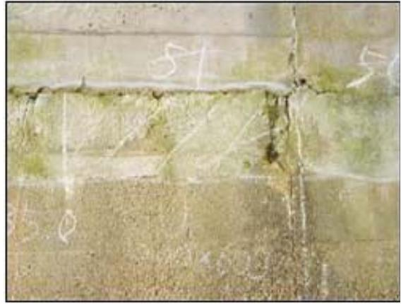
写真-9 縦断方向の目地の「うき」
