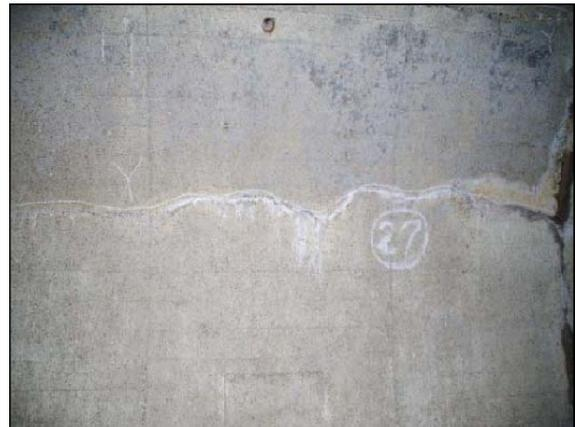
写真-7 縦断方向のひび割れ（天井部）
