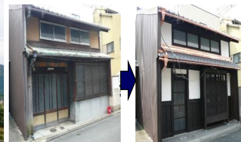
京町家の修理修景の事例
