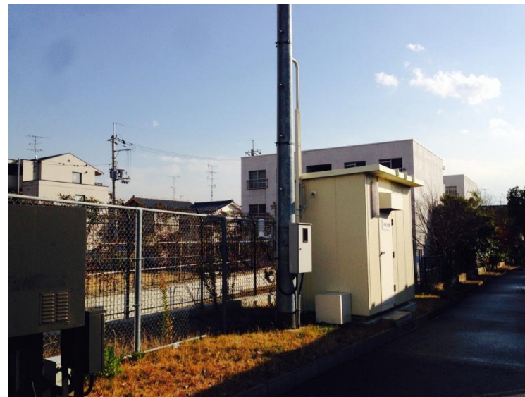
鴨川東環境測定施設 (写真奥が南)
