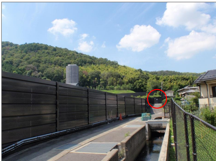
山科環境測定施設 遠景 (写真奥が西)
