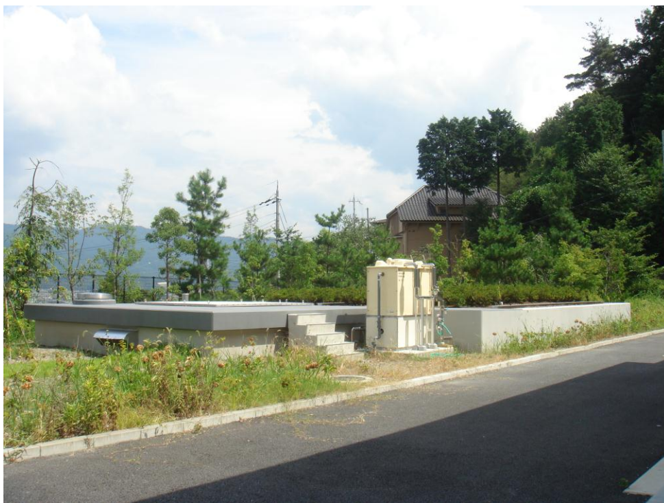
山科土壤脱硝施設
