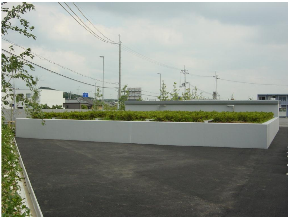
十条土壤脱硝施設
