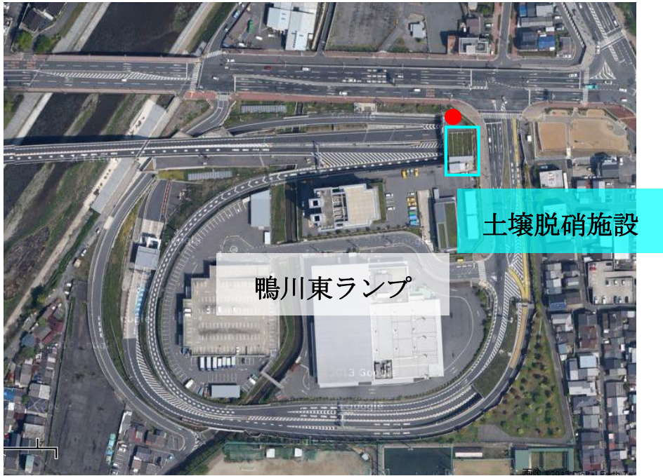
図1 鴨川東 調査箇所
