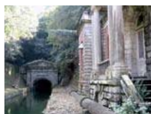
⑧ 第3トンネル出口部分
