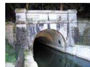
⑤ 第2トンネル入口部分
