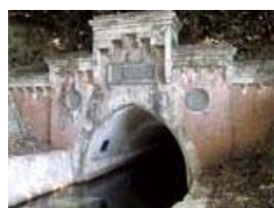
⑥ 第2トンネル出口部分
