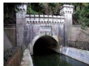
⑦ 第3トンネル入口部分
