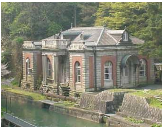
＜旧九条山浄水場ポンプ室＞
