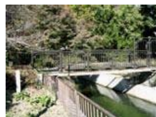
⑩ 日ノ岡第11号橋 (本邦最初鉄筋混凝土橋)
