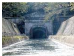
① 第1トンネル入口部分
