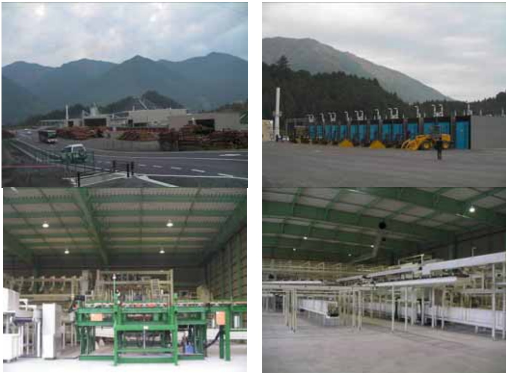
平成 22 年 11 月に操業を開始した協同組合兵庫木材センター(柱と間柱工場, 6 万 5 千 m 3 規模)
