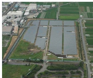
大規模太陽光（メガソーラー）発電所
