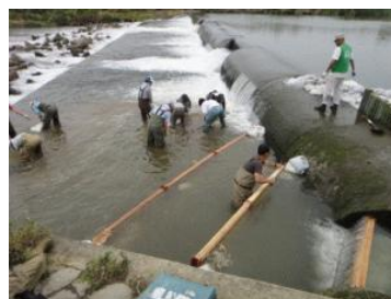
龍門堰に手づくり魚道を試験設置 (平成23年5月)
