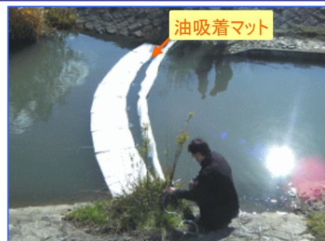
水質汚濁拡散防止措置の様子
