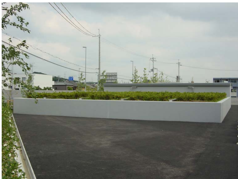
十条土壤脱硝施設
