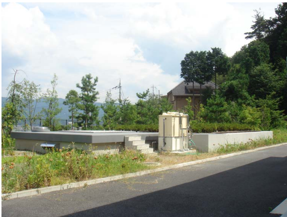
山科土壤脱硝施設
