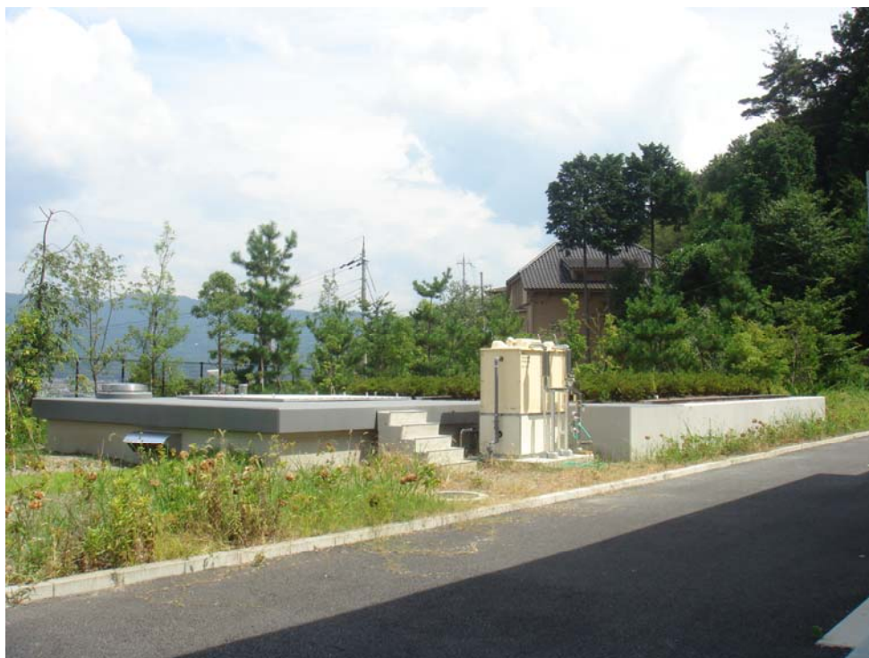
山科土壤脱硝施設
