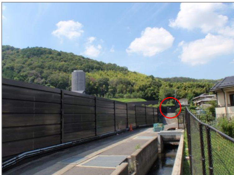
山科環境測定施設 遠景 (写真奥が西)
