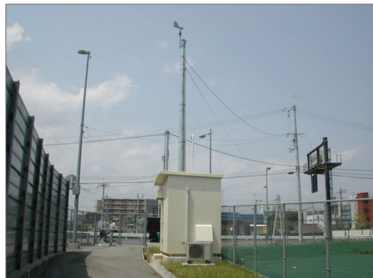
鴨川東環境測定施設 (写真奥が北)
