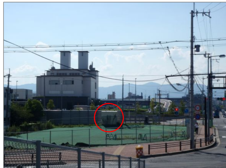
鴨川東環境測定施設 遠景 (写真奥が西)
