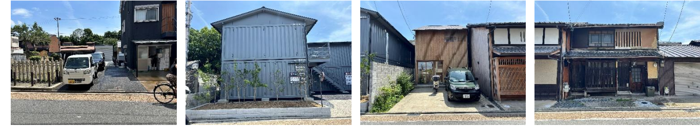
e10-1 1階建倉庫。 旗竿敷地に建ち、D/H最大(5.4)。建物越しに東福寺塔頭霊雲院の樹林が見える。(建築年代不明)
