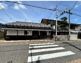
w19-1 1階建住宅。 塀が土壁・板張りであり、主屋も塗壁・板張り、建具木製。自然素材利用が路線内で最大。(建築年代不明)
