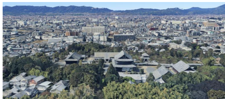
東から西への俯瞰(東福寺側→西側の住工混在)
